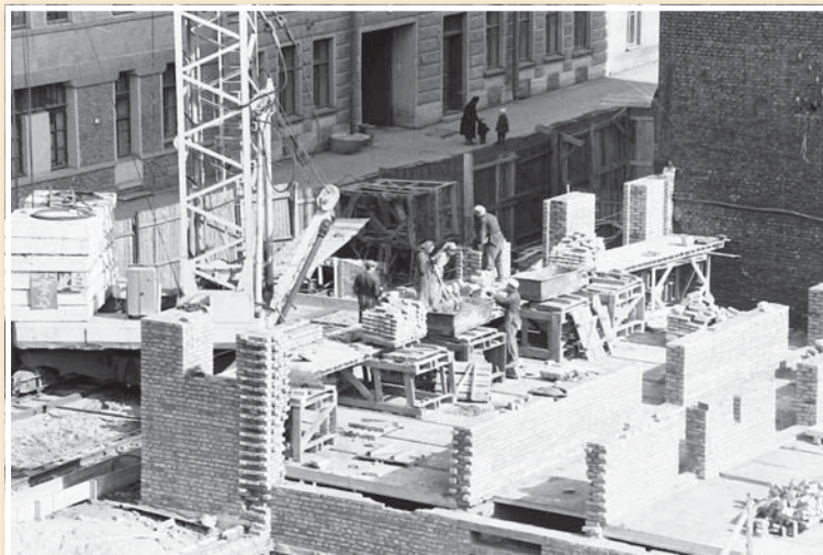
1966. Строительство корпуса Лодманская, 10
